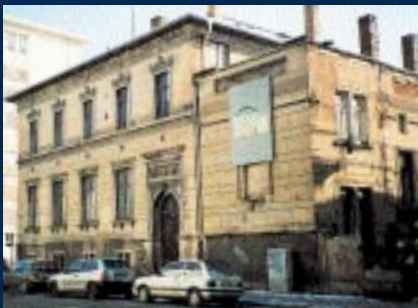
Gustav-Adolf Straße Objekt vor Sanierung
